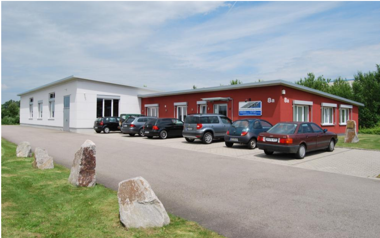
Neubau Produktionsgebäude und Büro, Sasbach 2008
