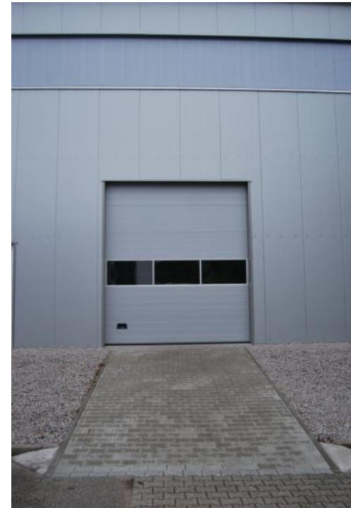
Neubau Lager-/ Produktionshalle, Achern 2011
