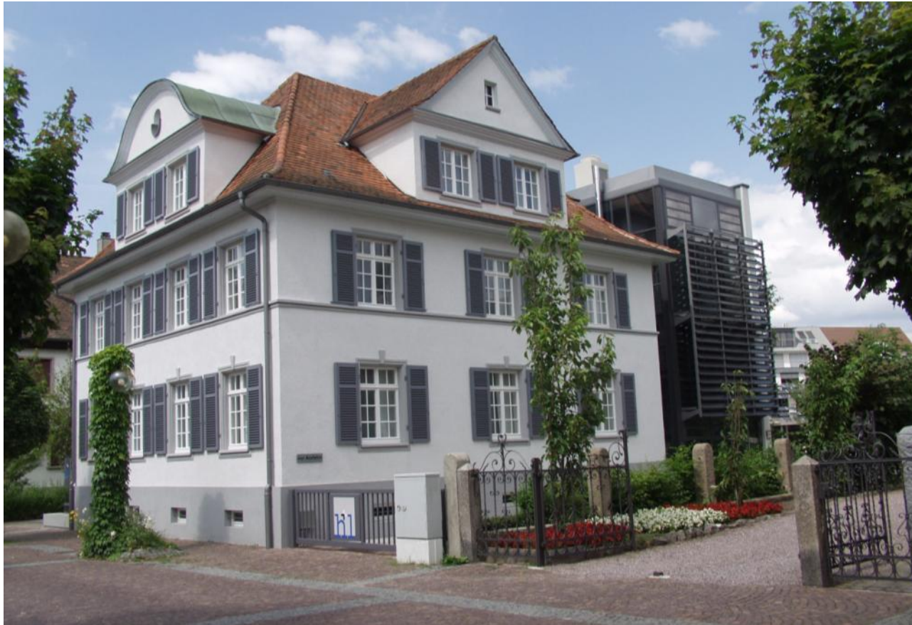
Sanierung und Anbau, Steuerberaterkanzlei, Achern 2003
