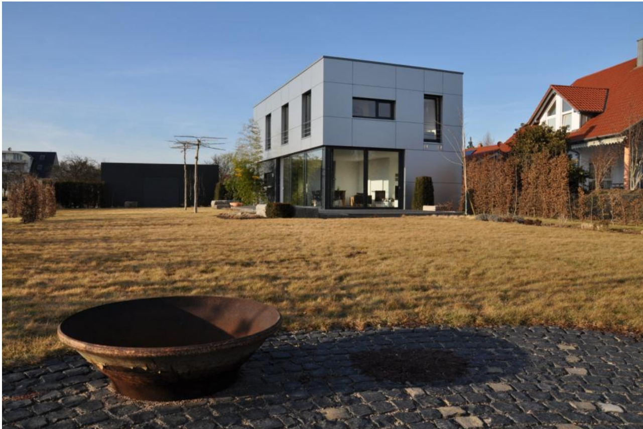
Neubau Haus K, Achern 2009
