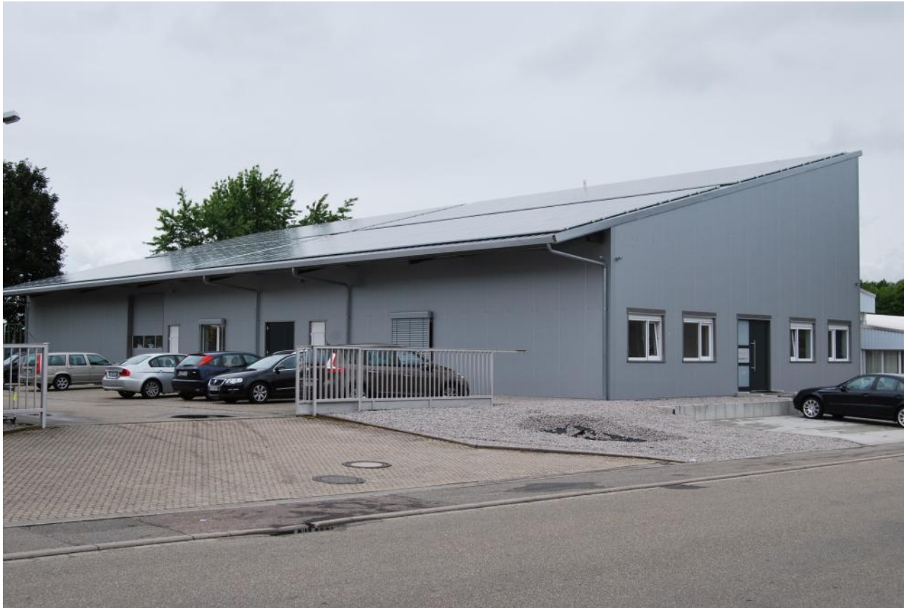
Neubau Lager-/ Produktionshalle, Achern 2011
