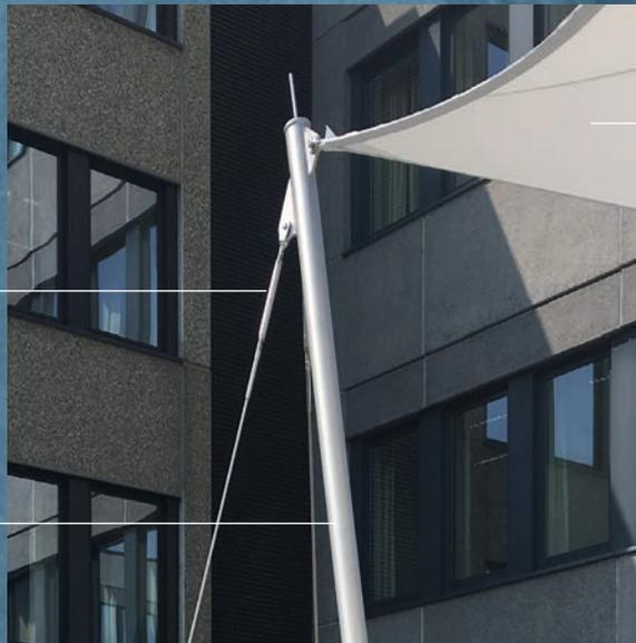
Seilabspannungen aus Edelstahl ■
