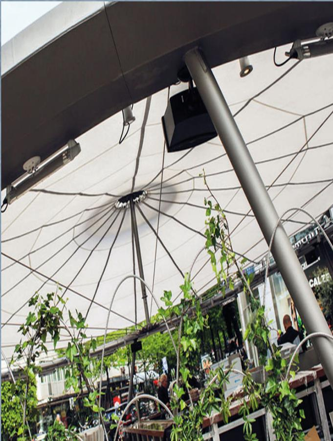
Das aerosun® SPIDERNET ist eine verfahrbare Dachkonstruktion. Sie besteht aus einem zentralen Motor, Seilen, einer umlaufenden Stahlkonstruktion, integrierten Getrieben und einer lichtdurchlässigen Membrane aus aeroflon® PTFE Gewebe. Es sind unterschiedliche Geometrien, wie beispielsweise rund, oval, quadratisch, rechteckig und hexagonal möglich.
