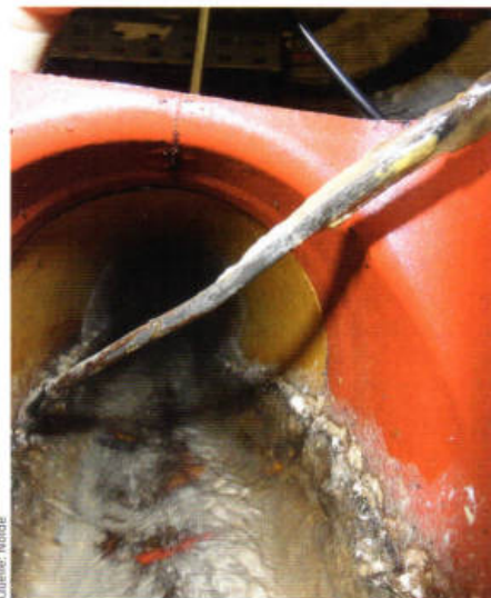
4 – Innenansicht des gedämmten SML-Abwasserrohrwärmetauschers AWT 2 (links) und der im Betriebswassertank getauchte Rohrwärmetaucher AWT 4 (rechts) nach ca. zweijährigem Betrieb
