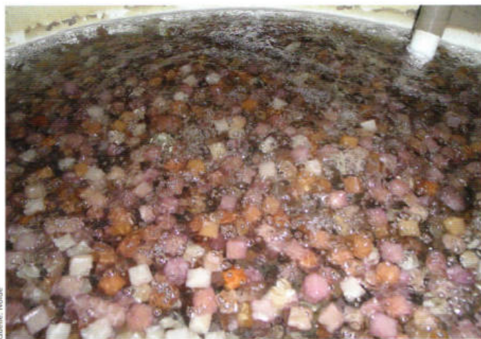
7 – Blick in die biologische Grauwasseraufbereitungsstufe. Das Wirbelbett mit Schaumstoffwürfeln nach einer 15-jährigen Betriebszeit ohne bisherigen Austausch der Reinigungskörper
