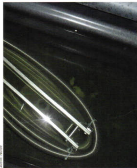
4 – Innenansicht des gedämmten SML-Abwasserrohrwärmetauschers AWT 2 (links) und der im Betriebswassertank getauchte Rohrwärmetaucher AWT 4 (rechts) nach ca. zweijährigem Betrieb
