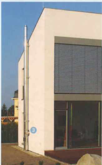
3 Aussenschornstein mit Schornsteinsockel als Bodenmontage
