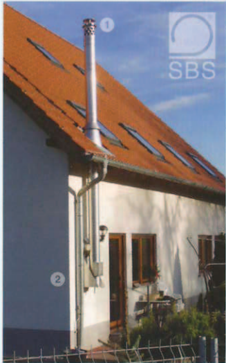
2 Aussenschornstein Edelstahl/matt auf Konsole an Wand befestigt
