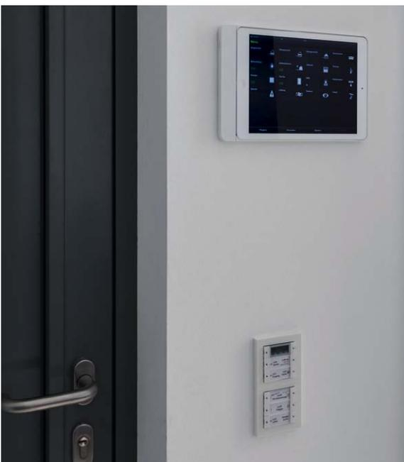
Das Smart Home ist gerüstet für die Zukunft: Die Haustechnik ist via KNX vernetzt, alle Komponenten lassen sich zentral und in Abhängigkeit zueinander steuern. Die Steuerzentrale im Hintergrund ist ein Gira HomeServer, bedient wird u. a. über ein iPad.
