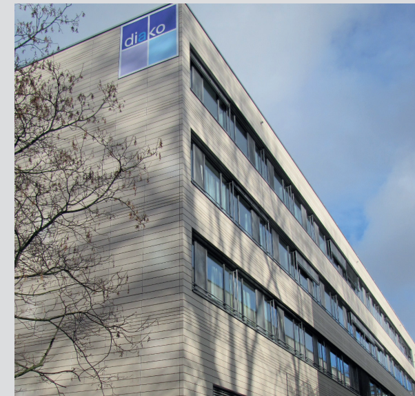
Krankenhaus, Evangelische Diakonissenanstalt Augsburg
