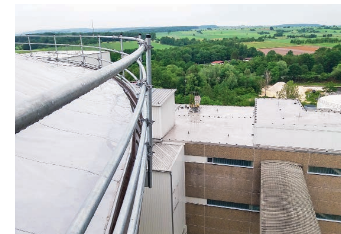
▲ Die Anschlusspunkte liegen an der Außenseite des Dachrands
