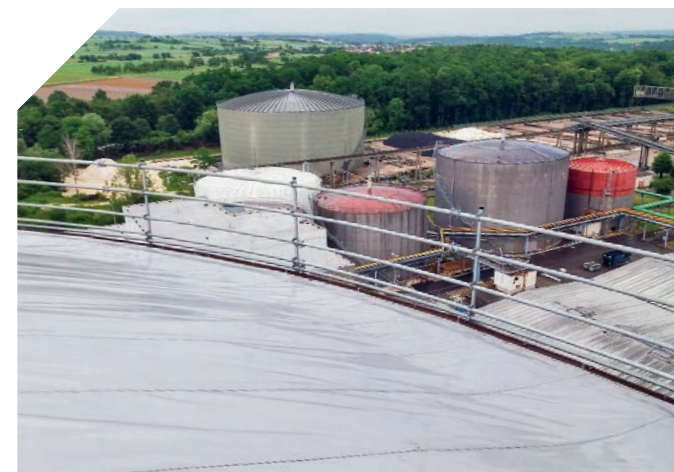
▲ Die Gerüste passen sich der runden Dachkonstruktion individuell an
