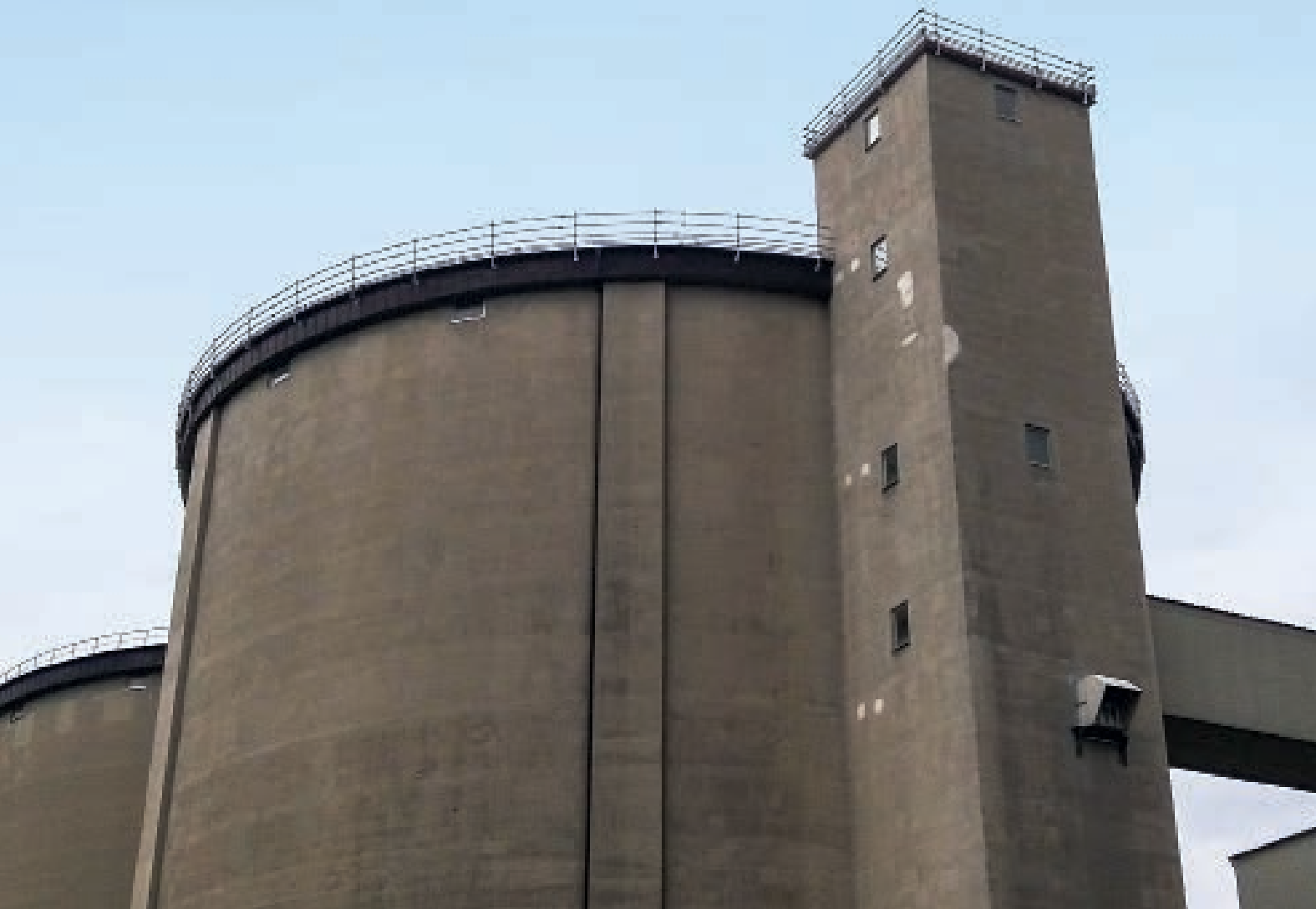
▲ Da das alte Dachgeländer dieses Silos der Südzucker AG nicht mehr die notwendige Stabilität aufwies, bedurfte es einer zuverlässigen Absturzicherung
