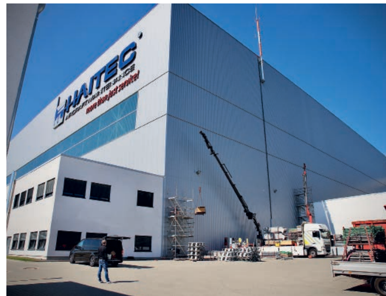
▲ Auf der 37 m hohen Halle wurden 470 m Seitenschutzgeländer aufgebaut
