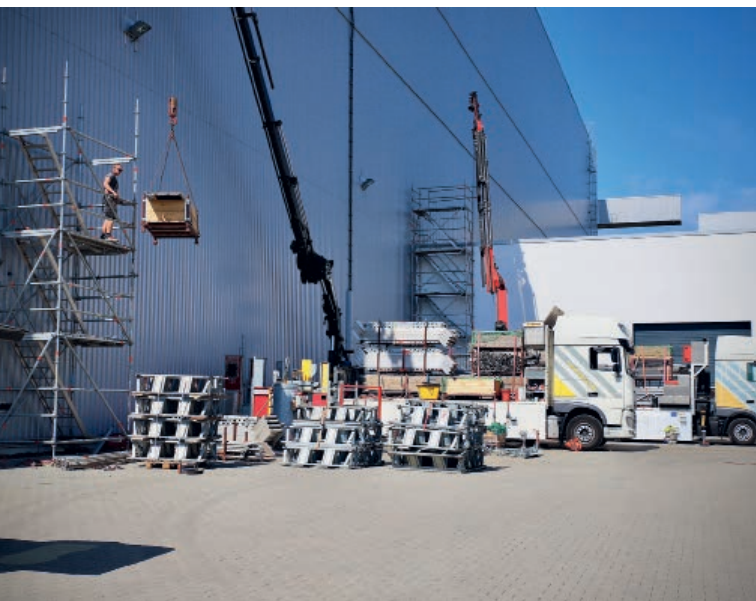
▲ Sicherer Zugang zur Dachbaustelle: Aufbau der beiden Treppentürme
