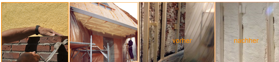
Sprühdämmung außen
