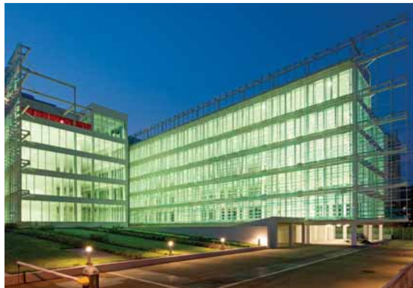
Fig. 25 – Vista notturna delle chiusure vetrate
