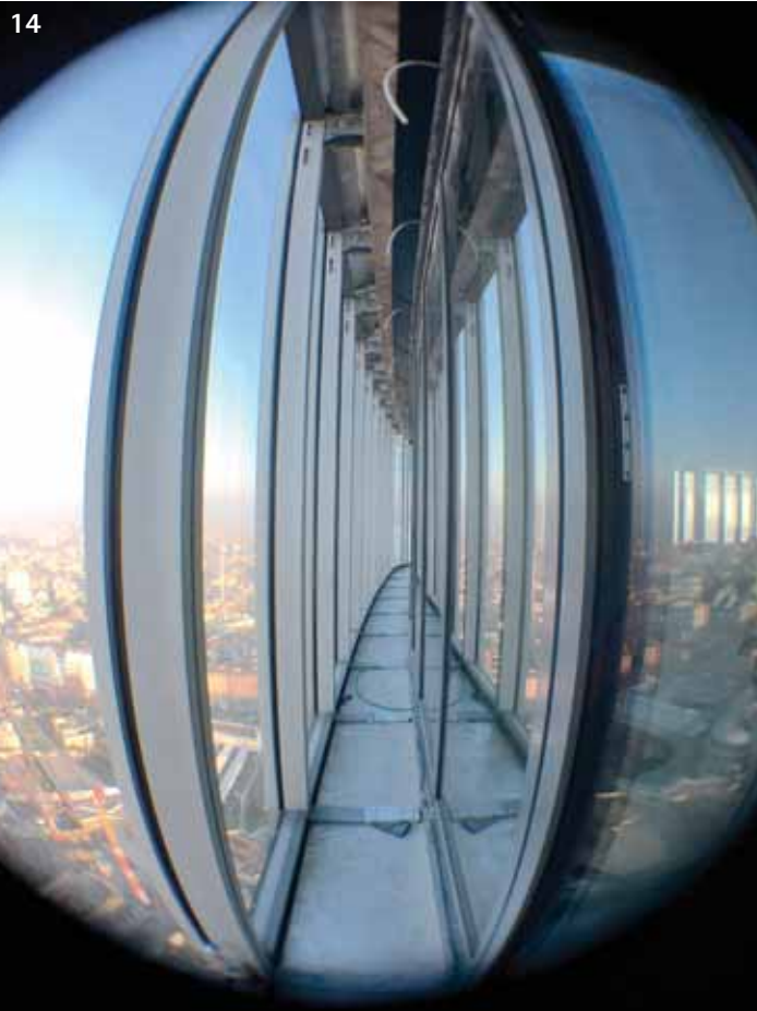
Fig. 13 - Facciata a doppia pelle con canale verticale unico. Fig. 14 - Facciata a doppia pelle, Torre Hadid - Milano - Particolare intercapedine ventilata. Fig. 15 - Facciata a doppia pelle ad elementi
