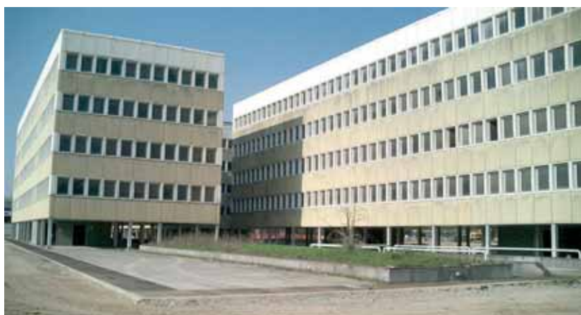
Fig. 4 - Vista dei tre corpi esistenti
