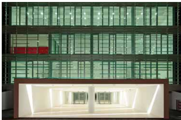
Fig. 35 – Vista notturna del tunnel di ingresso
