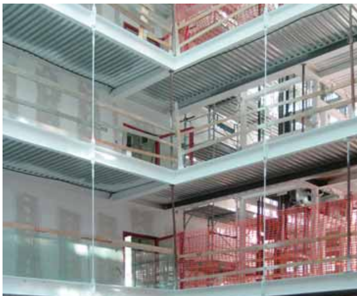
Fig. 17 - Cantiere durante la costruzione dei ballatoi
