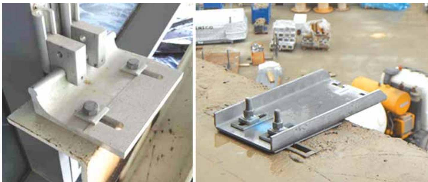
Fig. 17 - Staffa tipologica per facciata continua posata oltre l'escursione dell'asola
