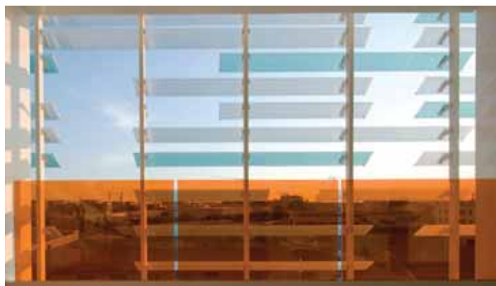
Fig. 30 - Dettaglio del sistema frangisole dall'interno di una loggia
