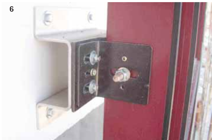
Fig. 1 - Esempio di attacco sulla testa del solaio. Fig. 2 -Esempio di attacco sopra il solaio. Fig. 3 -Esempio di attacco sotto solaio. Fig. 4 - Esempio di attacco sulla testa del solaio. Fig. 5 - Staffa di ancoraggio che permette la regolazione in direzione X e Y. Fig. 6 - Particolare dell'interfaccia tra piastra e montante
