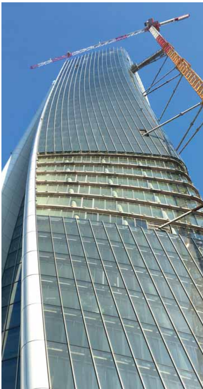
Fig. 11 - Facciata a doppia pelle Torre Hadid - Milano - Involucro vetrato
