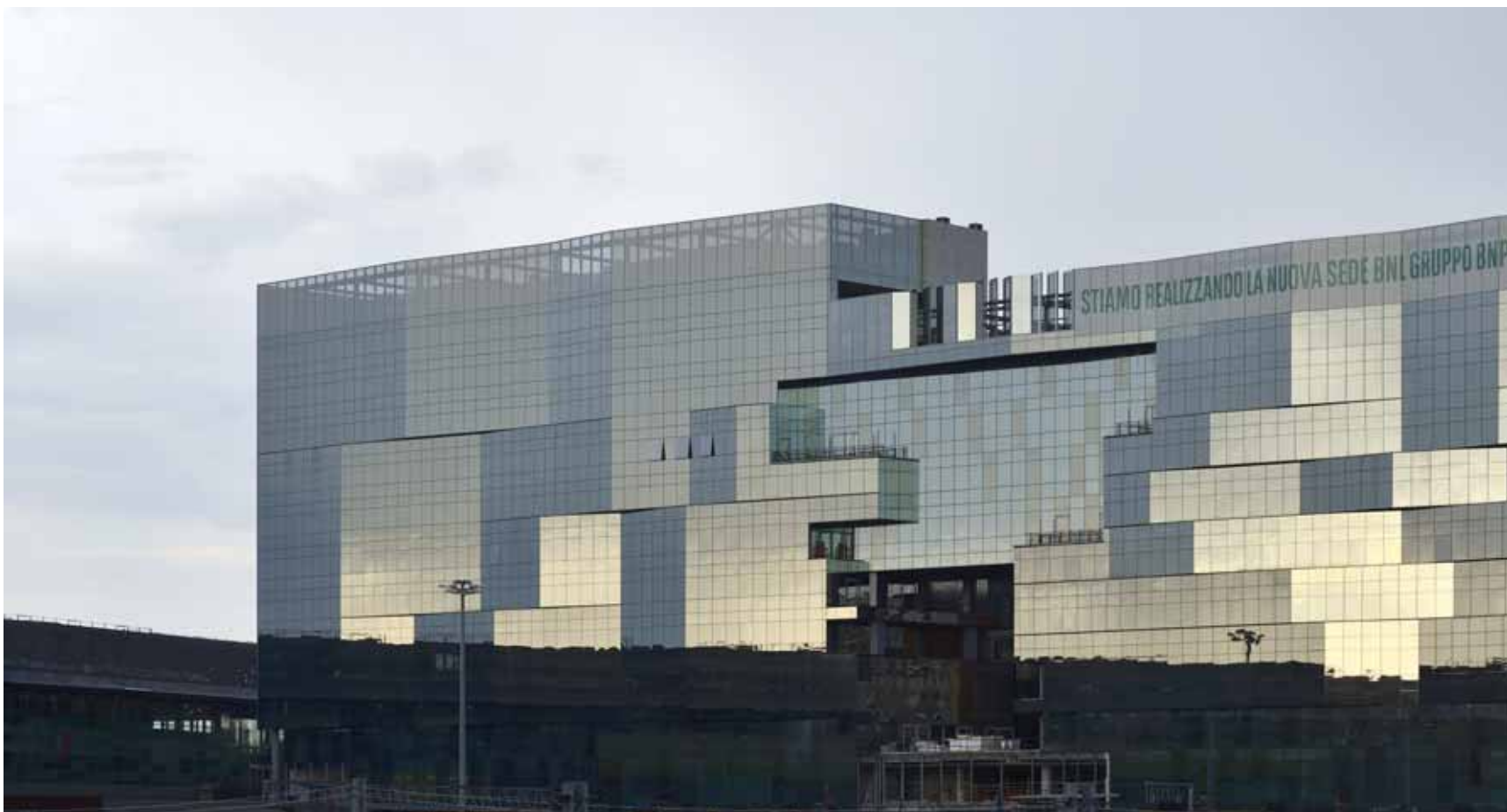
Fig. 6 - Il ponte realizzato nel corpo di fabbrica lascia libera la vista sulla Cisterna Mazzoni
