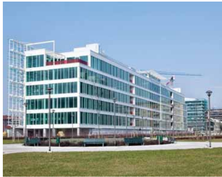
Fig. 8 - Vista dell'edificio da nord-est
