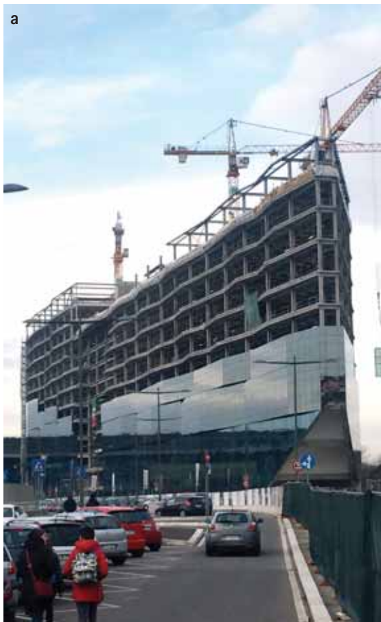
Figg. 7a, 7b - Il montaggio delle facciate
