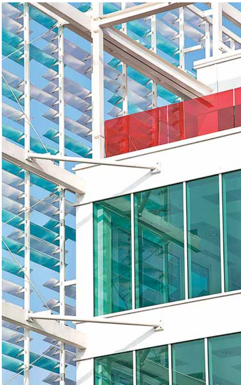
Fig. 28 - Dettaglio della struttura di sostegno del sistema frangisole
