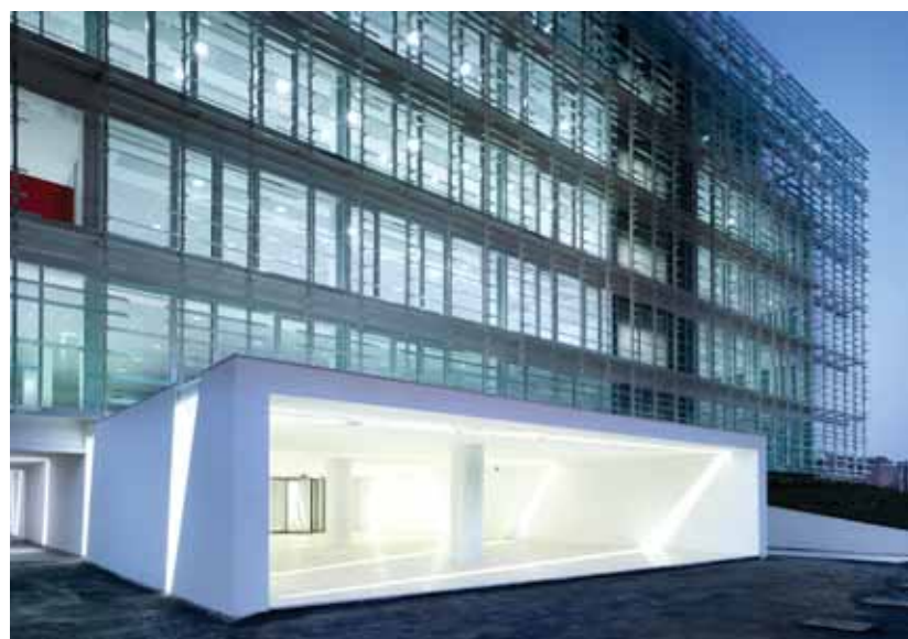
Fig. 26- Vista notturna del tunnel di ingresso all'atrio
