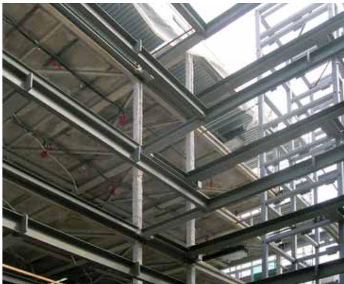
Fig. 16 - Cantiere durante costruzione della struttura di sostegno dei ballatoi
