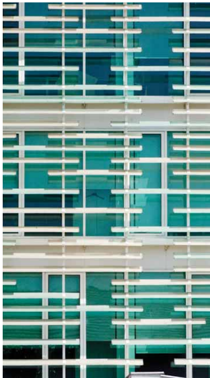
Fig. 31 - Dettaglio del sistema frangisole ripreso alle ore 14 del solstizio estivo: la chiusura vetrata è completamente ombreggiata dalle lamelle in policarbonato alveolare
