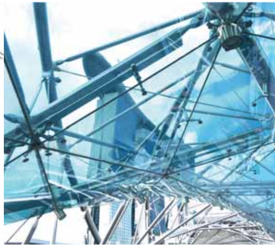
Fig. 9 - Tipologia di fissaggio puntuale in geometrie complesse
