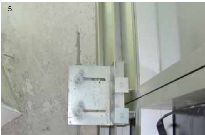
Fig. 1 - Esempio di attacco sulla testa del solaio. Fig. 2 -Esempio di attacco sopra il solaio. Fig. 3 -Esempio di attacco sotto solaio. Fig. 4 - Esempio di attacco sulla testa del solaio. Fig. 5 - Staffa di ancoraggio che permette la regolazione in direzione X e Y. Fig. 6 - Particolare dell'interfaccia tra piastra e montante
