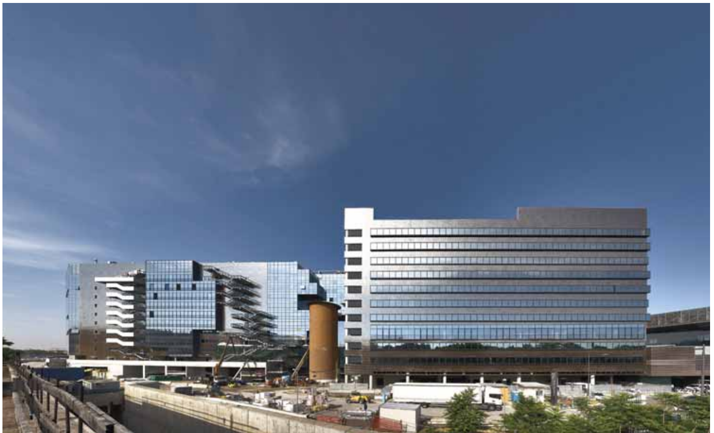
Fig. 3 - Facciata lato est
