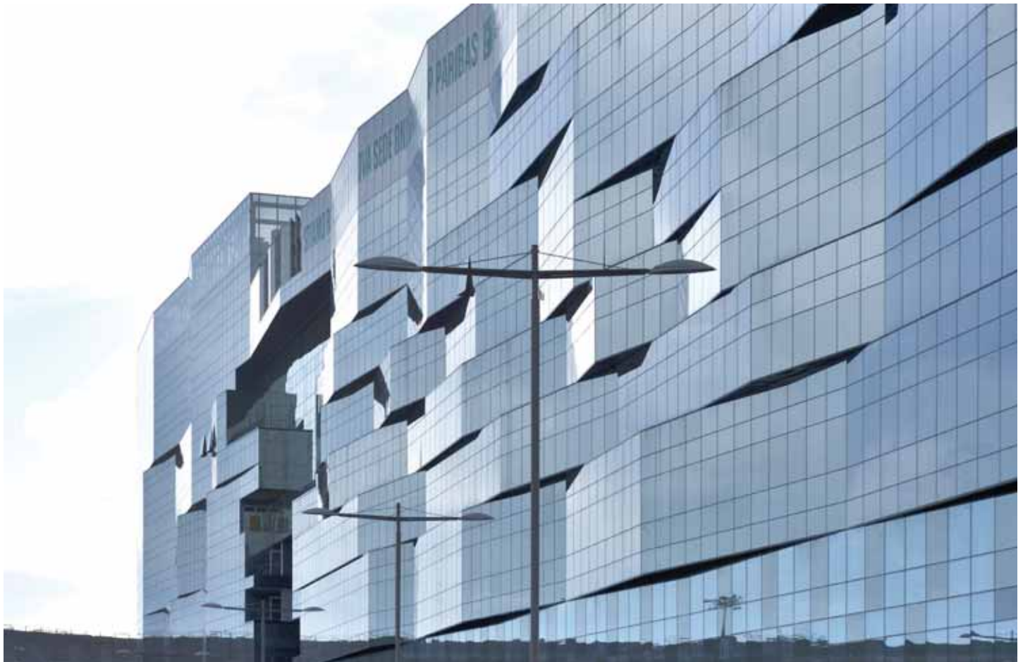
Fig. 2 - Facciata lato ovest
