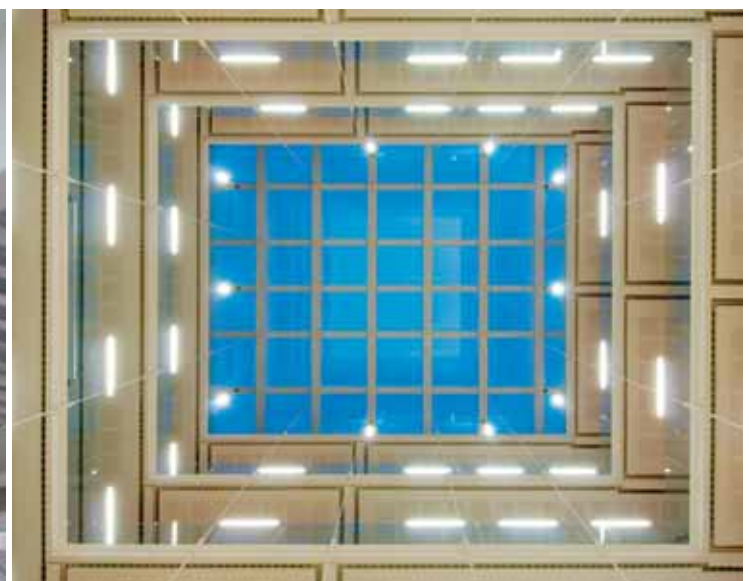
Fig. 20 - Vista dal basso della copertura vetrata dell'atrio di distribuzione.
