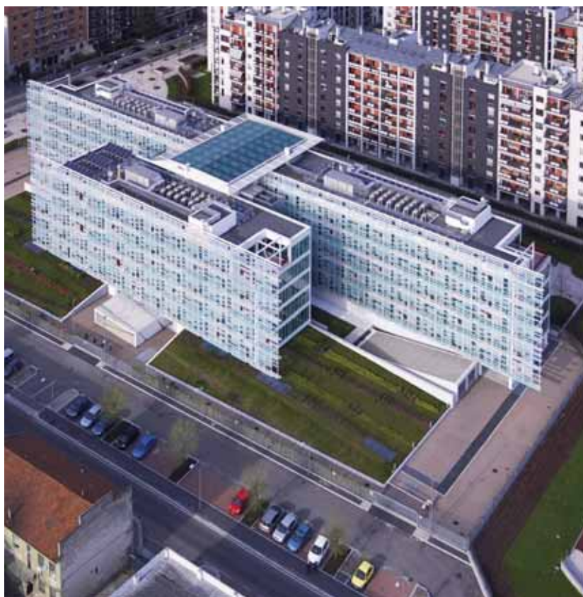
Fig. 5 - Vista dell'edificio dall'alto
