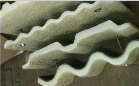
Wellblech- oder Trapezdach, glatte oder raue Oberflächen, Kanten oder Kurven: Die Komponenten der Sprühdämmung werden maschinell unter Druck und im geeigneten Mischverhältnis vor Ort aufgebracht.
