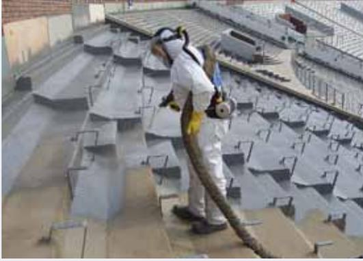
Sprühbeschichtung schafft flüssigkeitsdichte, chemie Resistente, flexible Flächen, Schutz von Beton und Stahl.
