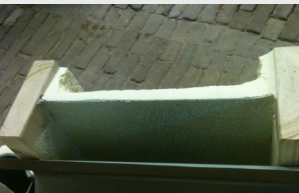
Sprühdämmung auf Dämmnetz Zwischen den Sparren
