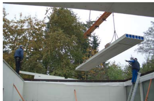
Bild 8: Montage eines Spannbetonhohlkörper-Elements der Zwischengeschosdecke.
