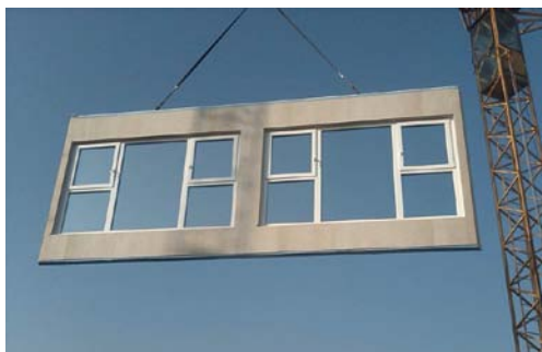
Bild 3: Heben eines Wandelements, Fenster bereits ab Werk eingebaut.
