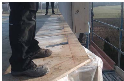
Bild 2: Absetzen des Wandelements, Befestigungswinkel am Boden bereits vormontiert.
