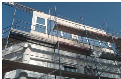
Bild 6: Abgesetztes Wandelement von außen.
