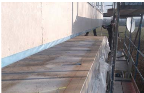
Bild 7: Absetzen des Wandelements, Befestigungswinkel am Boden bereits vormontiert.
