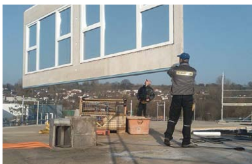
Bild 5: „Landing“ eines Wandelements.
