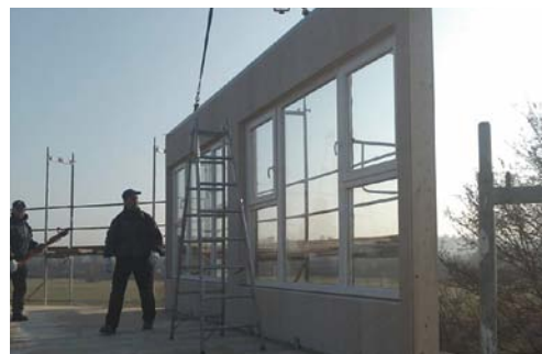
Bild 4: Abgesetztes Wandelement von innen.
