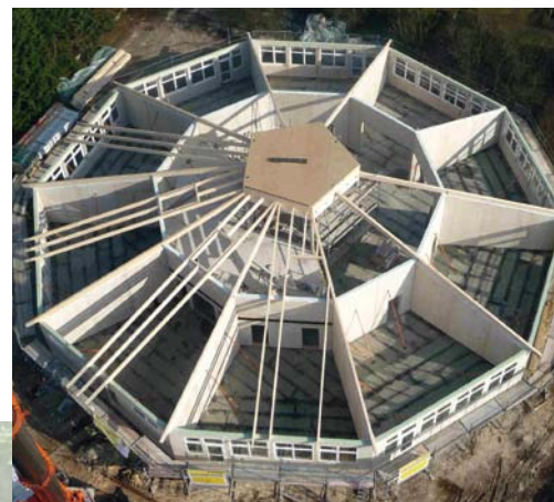
Luftaufnahme Grundschule Bröckel im Bau.
