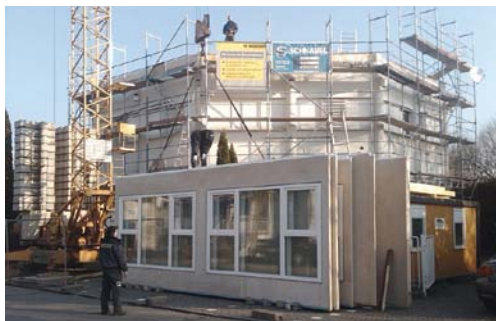
Bild 1: Anlieferung der Wandelemente.
