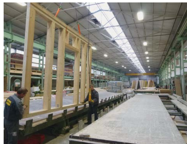
Fertigung einer Holzrahmenwand in Dauban.
