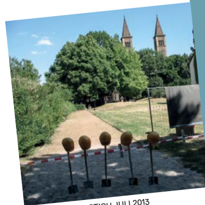
ERSTER SPATENSTICH JULI 2013
