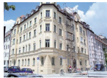
Münchner Stadthaus Holzhofstraße.
