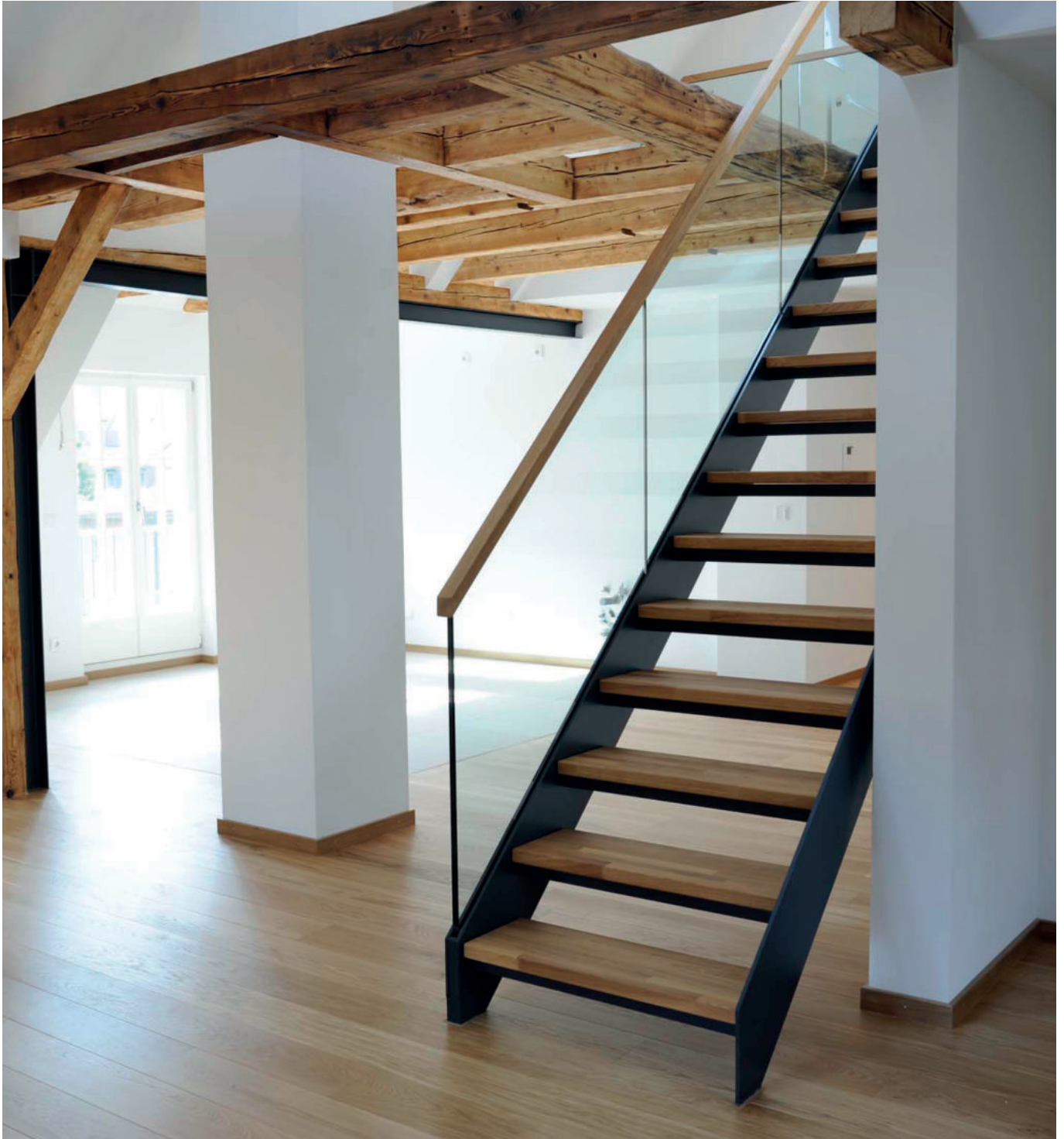
Objekt: Nürnberg, Villa Hertastraße Leistung: 265 m 2 Parkett verlegt und versiegelt plus 35 Treppenstufen
