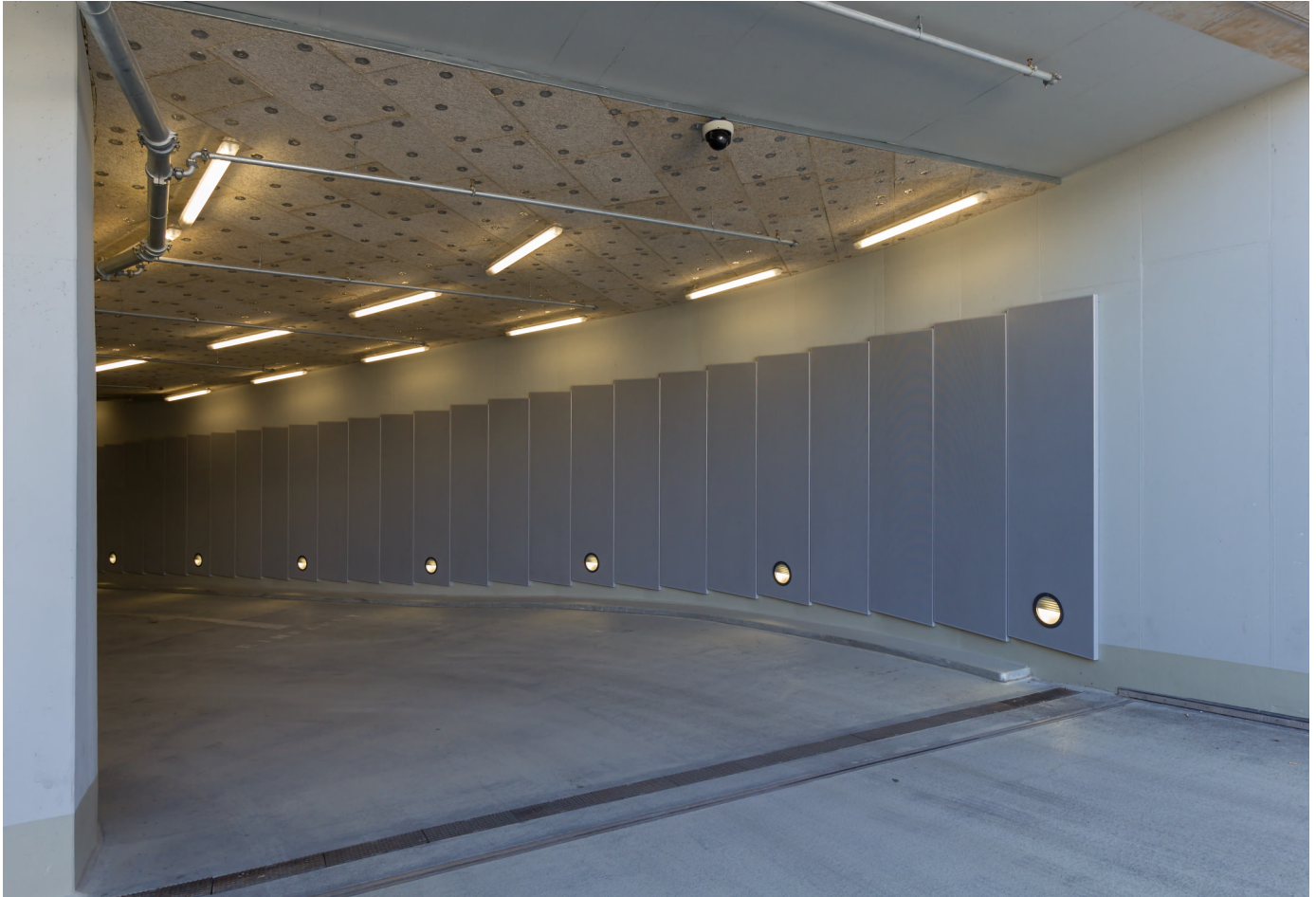
Einfahrtsrampe der Tiefgarage. (Bild 5 von 11)
