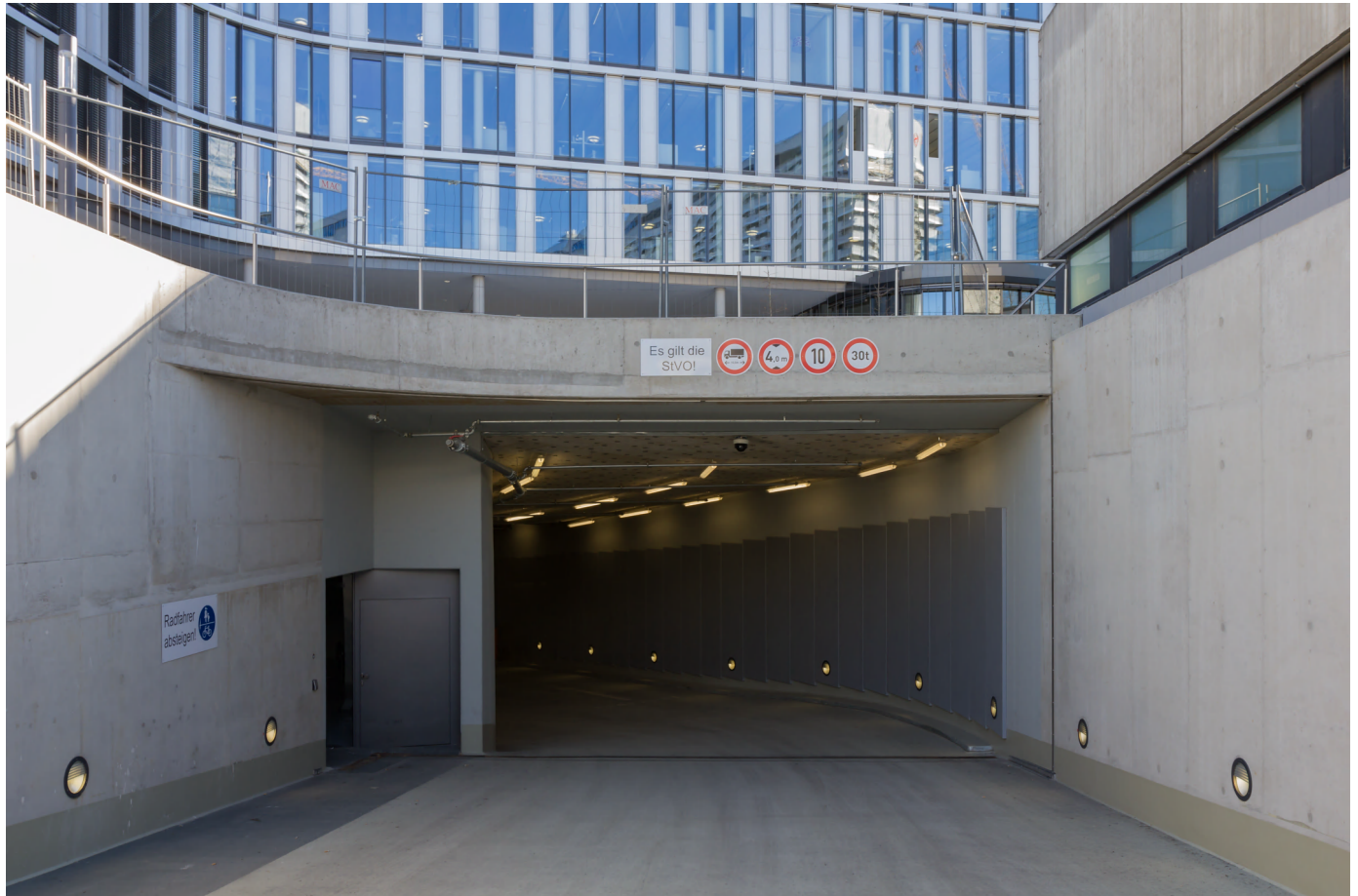
Einfahrtsrampe der Tiefgarage. (Bild 11 von 11)
