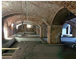
den Schichten dient. Eine Faserarmierung verhindert dabei Risse, damit die Sperrwirkung gegen Wasser in flüssiger Form dauerhaft erhalten bleibt. Die anschließende „Sulfatexschlämme“ fungiert als Haftbrücke für den „Grundputz“ nach WTA-Merkblatt 2-9-04/D, der ebenfalls faserarmiert und dampfdurchlässig ist. Er wurde in einer Stärke von 1,5 Zentimetern aufgetragen. Mit seinem Porenvolumenanteil von über 50 Prozent eignet er sich besonders für salzbelastete Untergründe.
