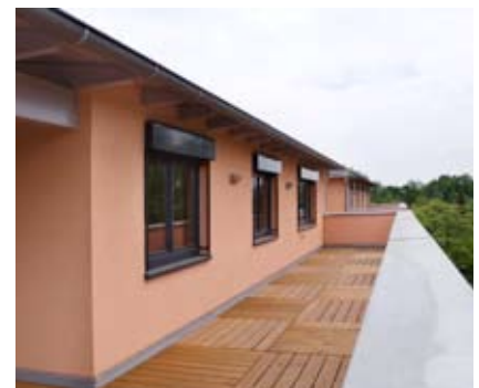
▲ Rückansicht des Firmengebäudes.
