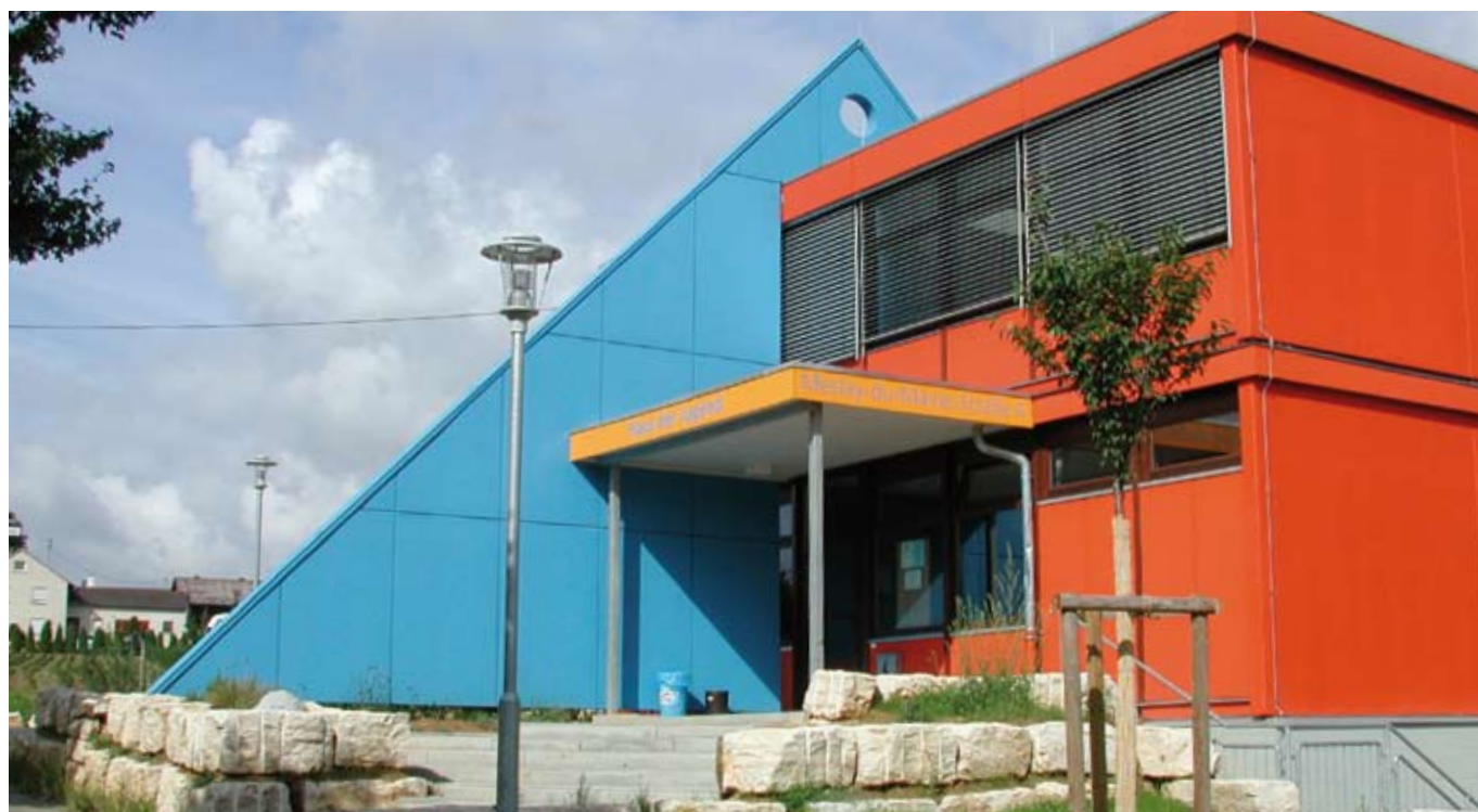
▼ Der Eingangsbereich mit Natursteinen umrandet.
