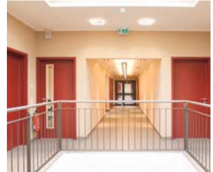
▲ Lichthof im Flur – damit für Licht und Frischluft gesorgt ist.
