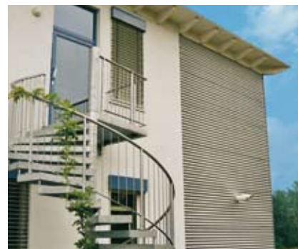
▲ Öffnung mit Aluverkleidung – hier können Geräte ausgetauscht werden.
