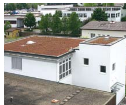
▲ Begrüntes Dach für besseres Raumklima.
