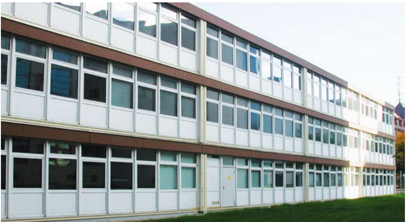
▼ Außenansicht der Gebäuderückseite.
