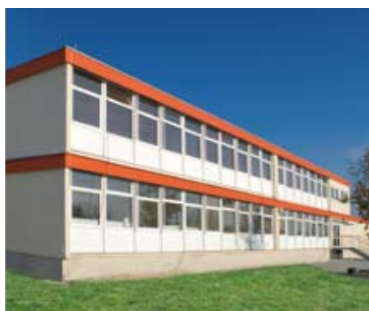
Frontansicht des Gebäudes. ▲
