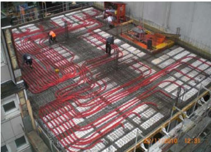
*Klimadecke für ein Bürogebäude in Ulm – bauseitiges Verlegen der Lüftungsrohre und Anschluss an werkseitig einbetonierte Drallauslässe*
