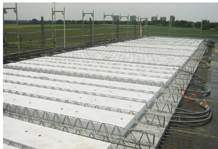
Untere Schale der Klimadecke mit Rohrleitungen zum Heizen und Kühlen
