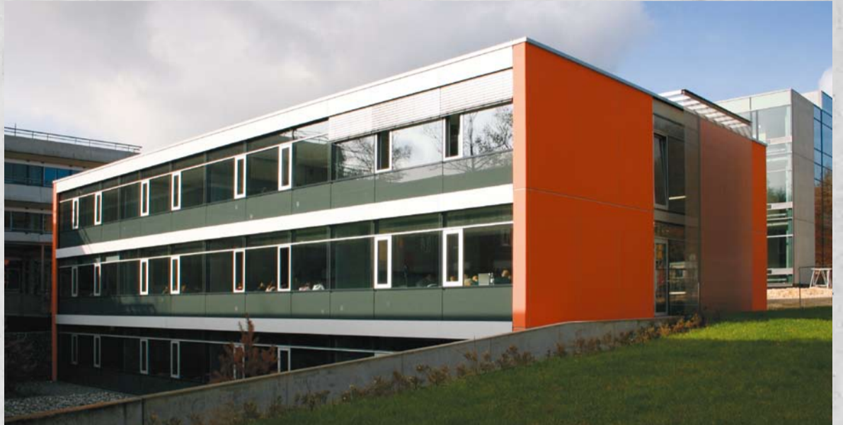
Teilansicht Hörsaal-Gebäude Universität Ulm, gefertigt auf einer EBAWE-Anlage
