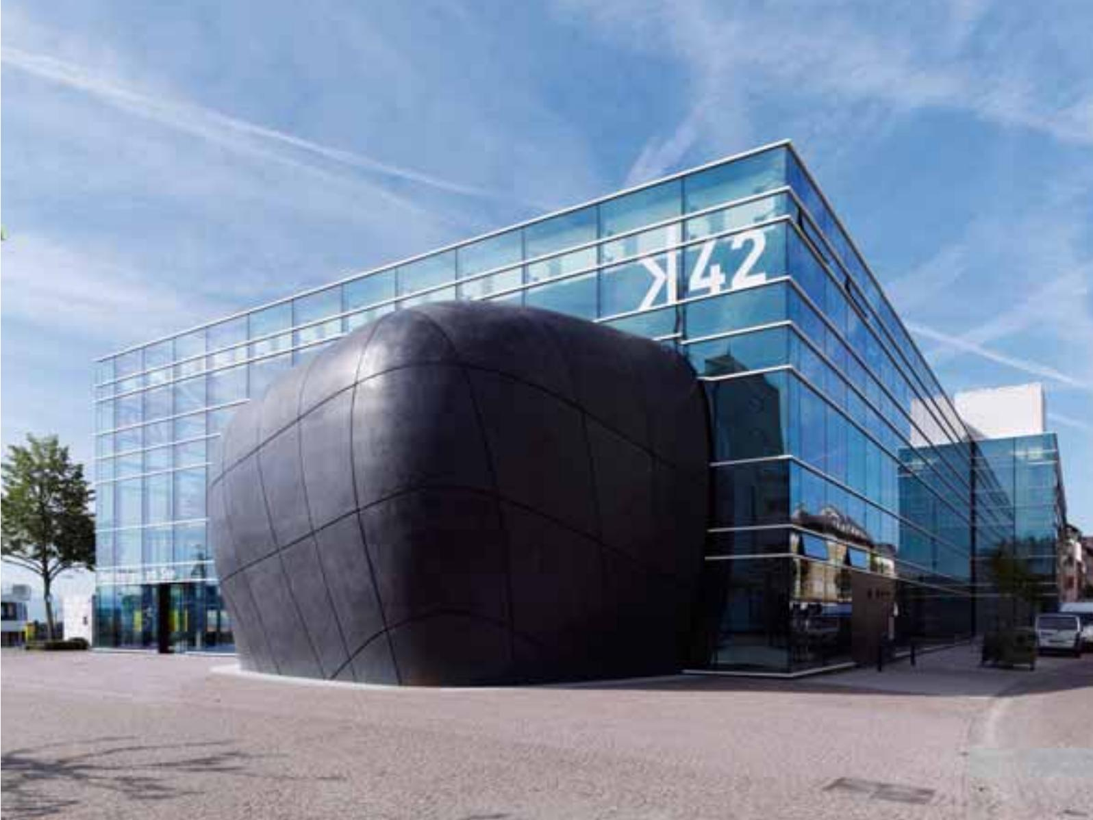
*Der „Bodenseekiesel“ – der Veranstaltungssaal des k42 aus Glasfaserbeton-Elementen schiebt sich durch die Glasfassade*
