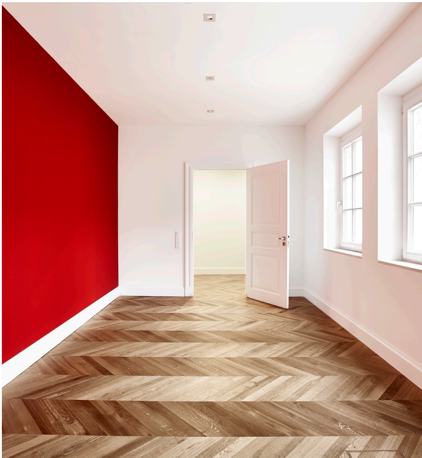
Objekt: Exclusive Büroflächen Promenadeplatz Leistung: Komplette Sanierung im Innenausbau, sowie 300 m 2 Stabparkett, französisch Fischgrät
