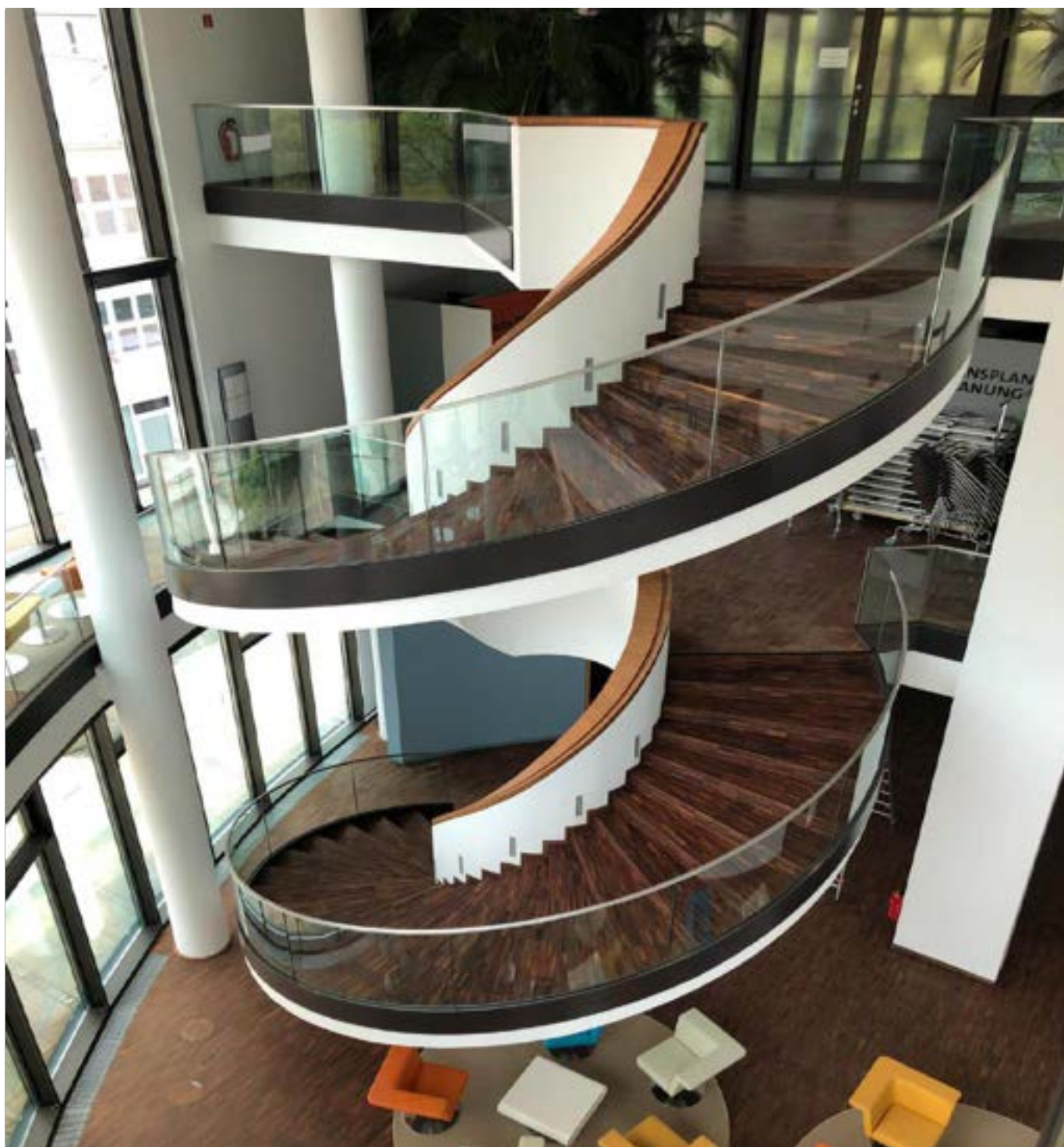
Objekt: Deutsche Vermögensberatung Conference Center in Marburg Leistung: 500 m 2 Sanierung von Holzböden
