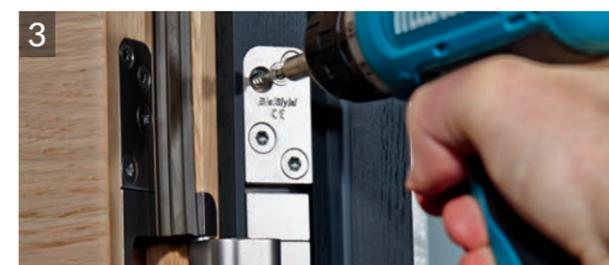
Das eingeführte **MASTERBAND FX2 120 3-D FD** wird in der Zarge mit handelsüblichen Schrauben verschraubt. Das Türelement ist nun fertig montiert.
