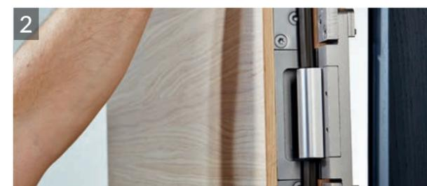
Das Türblatt wird mit der Zarge verbunden. Dazu werden die Bänder in die Zargenausfräsung eingeführt. Ein Montagewagen kann als Hilfestellung dienen oder aber auch Montagekissen, Keile, o.ä.
