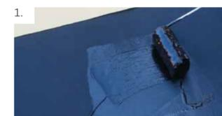
1. NACH REINIGUNG DES UNTERGRUNDES FG 35 MANUELL AUFTRAGEN.
