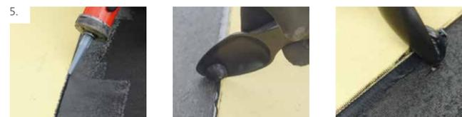
5. RÄNDER ZUSÄTZLICH MIT HERTALAN® KS 96 VERSIEGELN. BEI BITUMENBAHNEN IST ZU BERÜCKSICHTIGEN, DASS ABSÄTZE > 3 mm VOR DEN BITUMENBAHNENKANTEN IN DEN RANDBEREICHEN VON WALKWAY MIND. 4 cm MIT HERTALAN® KS 96 NACH INNEN AUSGEFÜLLT WERDEN MÜSSEN.
