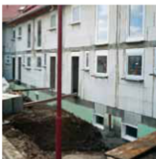
Leibungsblenden und teilmontierte Außendämmung
