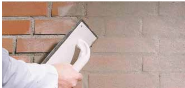
2 Aufziehen der Schlämme Nach mindestens 5 Tagen FM FS mittels Reibebrett ganzflächig auftragen. Durch Abziehen Überschüsse entfernen.
