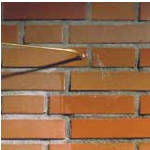
1 Vorimprägnierung Funcosil SNL drucklos im Flutverfahren auftragen.
