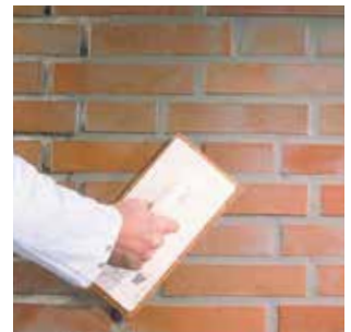
3 Verdichten und egalisieren Anschließend mit rotem Schwammbrett die Schlämme verdichten und egalisieren.
