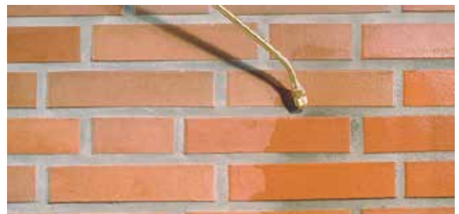
6 Nachimprägnierung Nach 8 Tagen die trockene Fassade ganzflächig mit Funcosil SNL nachimprägnieren.
