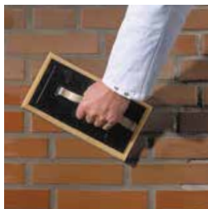
5 Endreinigung Im Frühstadium der Erstarrung die Endreinigung mit sauberem, klarem Wasser ausführen.
