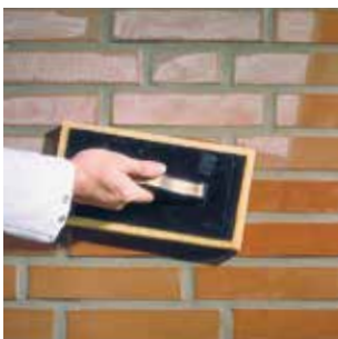
4 Nachreinigung Ca. 30 bis 60 Min. nach dem Ver- schlänmen mittels geschlitztem Schwammbrett (Schrägzug) die Oberfläche reinigen.
