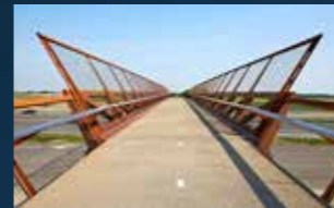
Bicycle bridge Hoofddorp (NL)
