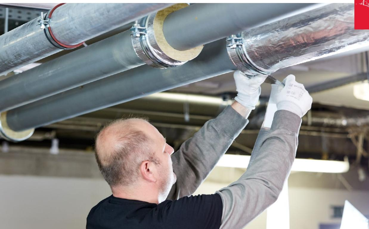
Das ROCKWOOL Aluminiumklebeband Teclit Alutape ist optimiert für die Verklebung von Dämmstoff-Stoßstellen, die hohen Temperaturbelastungen standhalten müssen. Es ist hochreißfest durch eine Glasfaserverstärkung und mit einem sehr klebestarken vernetzten Polyacrylat-Haftkleber ausgestattet und besitzt eine große Scherfestigkeit bei hoher Temperaturbeständigkeit.
