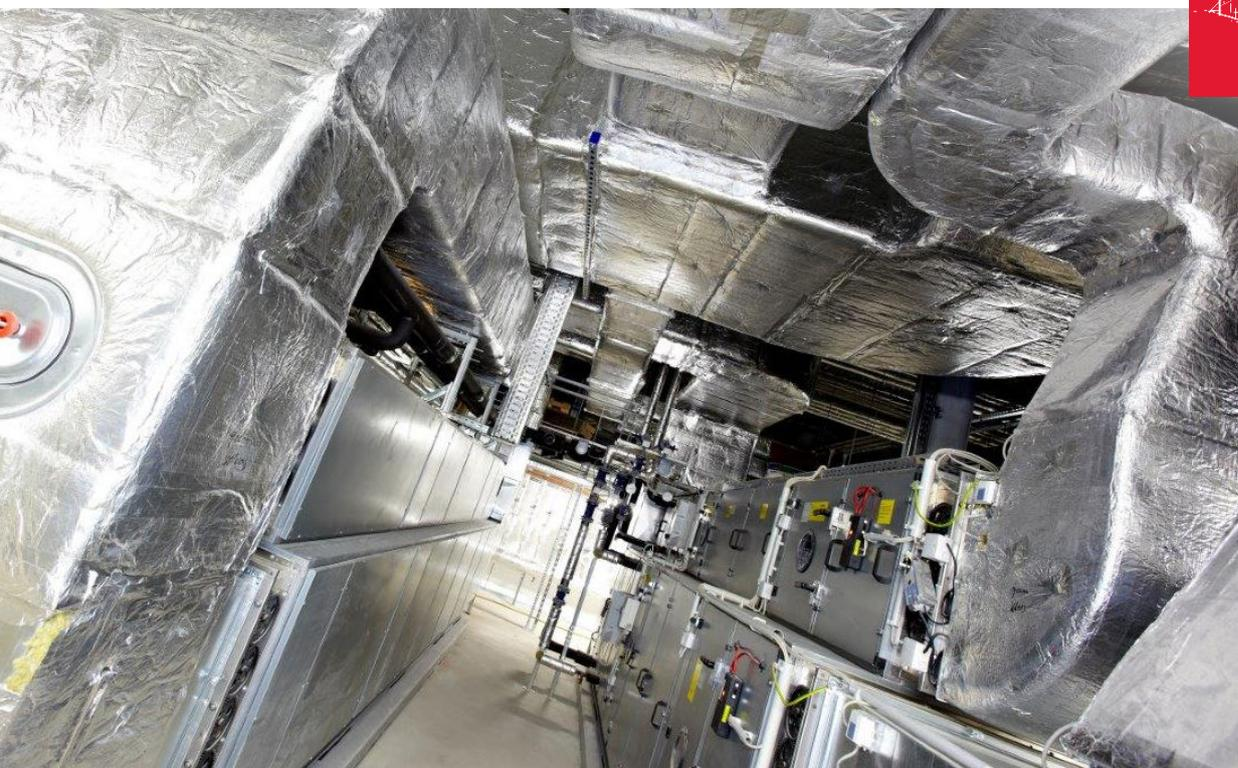
Die Steinwollematte Klimarock hat durch ein spezielles Herstellungsverfahren eine hohe Flexibilität bei gleichzeitiger Druckfestigkeit. Die Klimarock weist eine überwiegend senkrecht zur Mattenebene gerichtete Mineralwollestruktur auf. Sie ist einseitig mit einer gitternetzverstärkten Aluminiumfolie kaschiert.
