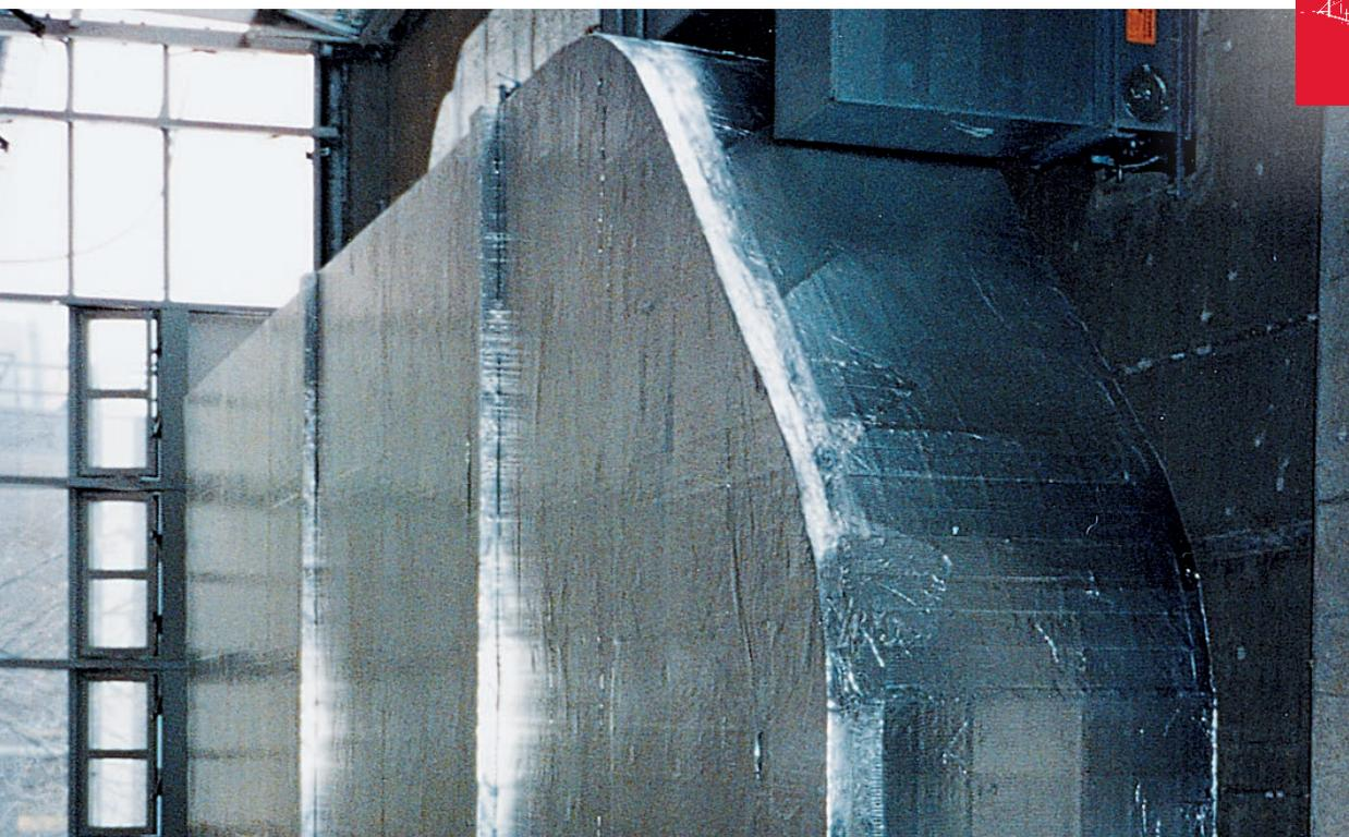
Die Dämmplatte Aluboard ist eine kunstharzgebundene Steinwolle-Dämmplatte mittlerer Rohdichte, die einseitig mit gitternetzverstärkter Aluminiumfolie kaschiert ist.
