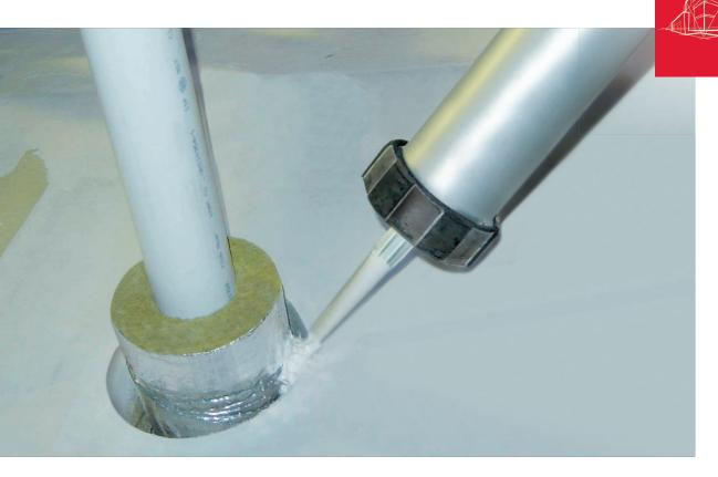
Conlit Kit ist ein lösungsmittelfreier, einkomponentiger Brandschutzkitt, der unter Hitzeeinwirkung (z.B. im Brandfall) stark aufschäumt. Hierdurch werden auftretende Fugen in Baukonstruktionen rauchdicht verschlossen. Conlit Kit kann in Verbindung mit allen Conlit Abschottungssystemen verwendet werden.
