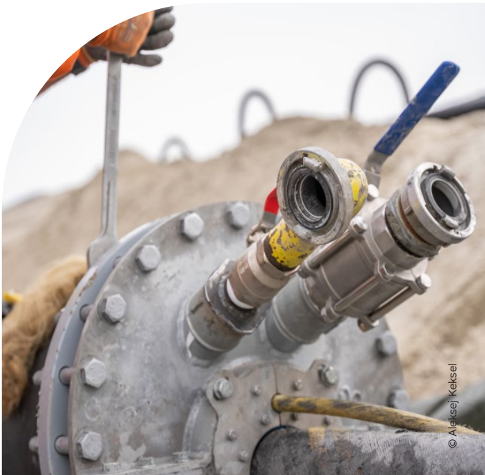
Ringraumverfüllung mit Silo (für größere Mengen)
