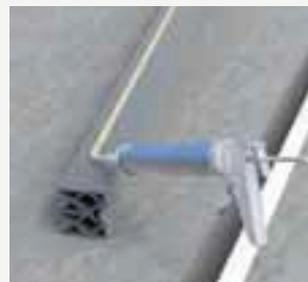
Eine Seite des KP-Profiles wird mit einem Streifen Neopren-Mastix bedeckt.
