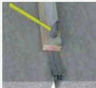
Danach wird das Profil mithilfe einer Holzleiste in die Fuge gepresst.
