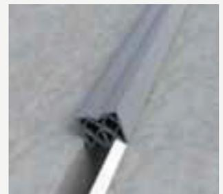
Das KP-Profil wird schräg auf einer Seite der Fuge eingesetzt und zusammengedrückt.
