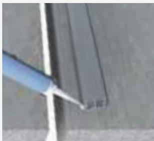
Ein Streifen Neopren-Mastix wird auf den Seitenflügeln des KP-Profiles aufgetragen.
