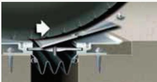
Bei herkömmlichen Profilen wird die Anfahr- und Bremskraft von Fahrzeugen auf den mittleren Befestigungsbolzen übertragen. Zuerst lockert sich dieser und schert dann ab.
