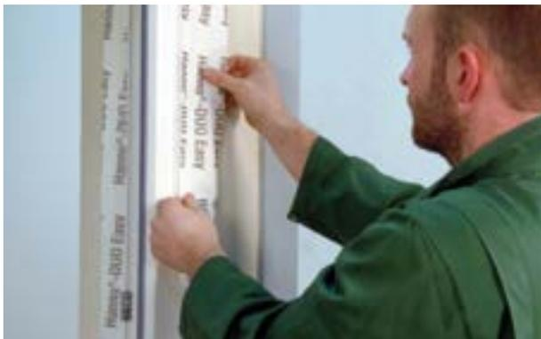
Das dehnbare Hanno®-Folienband DUO Easy 240 ermöglicht mit seiner vollflächig selbstklebenden Unterseite einen einfachen Einbau. Zudem ist das Folienband komplett überputz- und überstreichbar.
