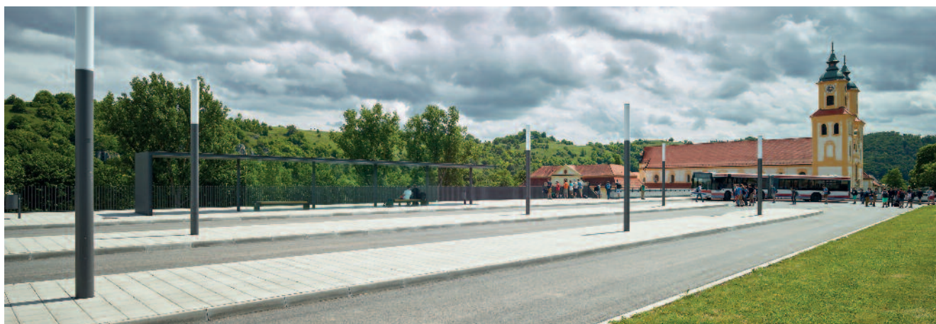
Verkehrsfläche über einem Bibliotheksmagazin mit Bushaltestelle für die Realschulen in Eichstätt-Rebdorf; FOAMGLAS® Platten S3, 16 cm, Fläche 2335 m 2 . Architekt: Diözesanbauamt Eichstätt. Foto: Jens Weber Photography, Munich
