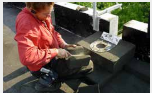
Einbau Ablaufkörper
