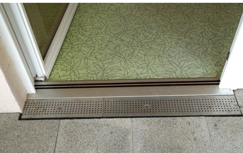
In mittlerweile 24 BeneVit-Pflegeheimen zeigt die Magnet-Nullschwelle, dass auch ohne Türanschlag kein Wasser ins Gebäude dringt.
