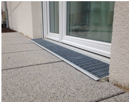
Die Magnet-Doppeldichtung mit direkt anschließender Rinne von ALUMAT. Foto: www.hilzinger.de
