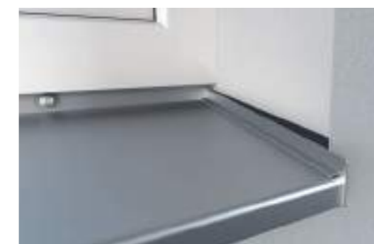
Schräge Laibung mit L-Abschluss
