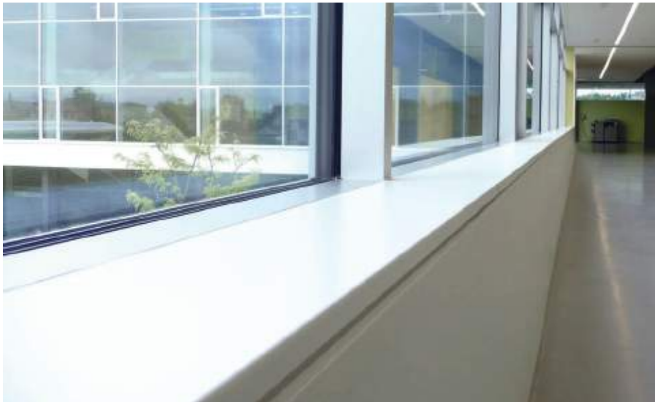
stumpfe Anbindung mit Anschlussprofil
