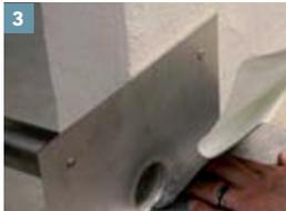
Durch Aufkleben der Watec® Fin Dichtmanschette\* wird ein dichter Übergang zur Estrichfläche bzw. zum aufgehenden Mauerwerk erzielt.
