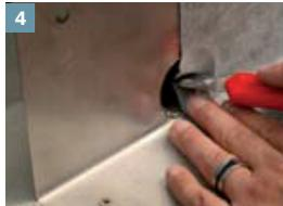
Der Lochbereich wird mit einem Cutter-Messer „sternförmig“ eingeschnitten und in Richtung Entwässerungsrohr umgeklappt sowie verklebt.
