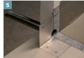
Die sich anschließende Überarbeitung der Flächenabdichtung aus einer für diesen Anwendungsbereich zugelassenen Dichtungsschlämme wird entsprechend deren Verarbeitungsanleitung ausgeführt.
