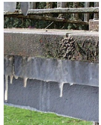
Schmutzfahnen sind unvermeidbar, wenn Oberflächenwasser unkontrolliert an der Stirnseite der Balkonkragplatte abläuft. Diese unansehnliche Ausführung ist im Mehrgeschosswohnbereich nach DIN 1986-100 unzulässig.
