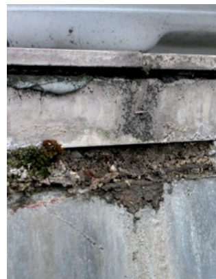
Schmutzfahnen sind unvermeidbar, wenn Oberflächenwasser unkontrolliert an der Stirnseite der Balkonkragplatte abläuft. Diese unansehnliche Ausführung ist im Mehrgeschosswohnbereich nach DIN 1986-100 unzulässig.
