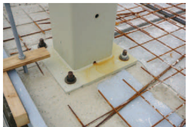
Abbildung 5: Montage ohne Spalt, hier beim Betonieren eines Deckenaufbetons
