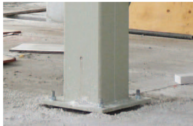
Abbildung 4: Verbundstütze mit Peikko Ankerbolzen montiert, vor dem Fugenverguss
