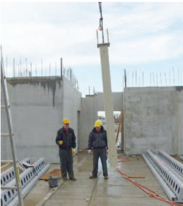
Abbildung 3: Aufstellen der Verbundstützen
