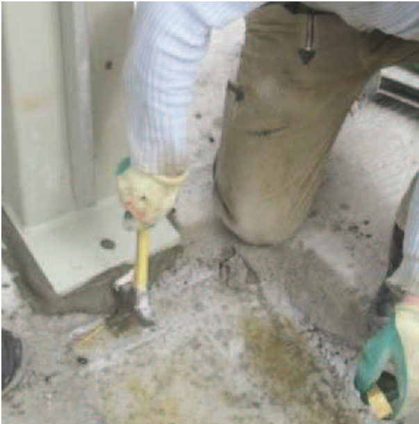
Abbildung 6: Ausrichten und Unterkeilen bei Direktmontage im Mörtelbett
