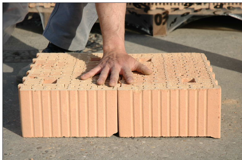
Geschliffene Seite nach oben ins Mörtelbett legen
