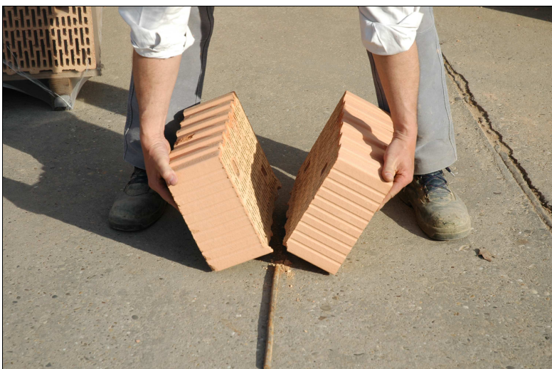
Trennen - Eigengewicht des Ziegels genügt
