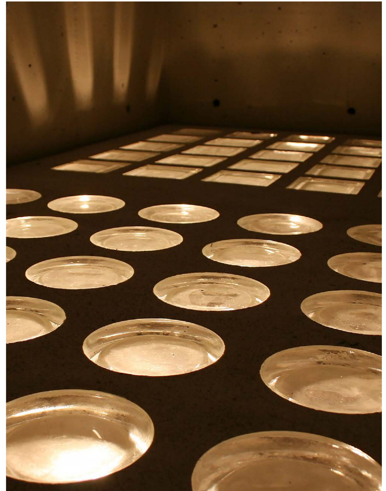
Halbschalen und Hohlbetonglas, klassische Verlegung in Beton Beleuchtete Musterwand in Kerken, Deutschland 2020
