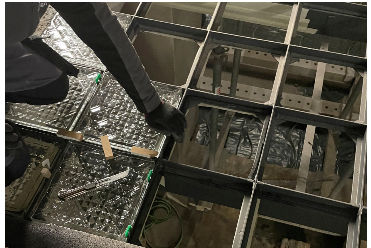
Betongläser Sonderanfertigung, 27,6 x 29,6 x 2,85 cm und 29,6 x 29,6 x 2,85 cm klassische Verlegung, FlexFuge-Verlegesystem Fußboden/Decke eines ehemaligen Tresors Mauerstraße, BMG Berlin, Deutschland 2022
