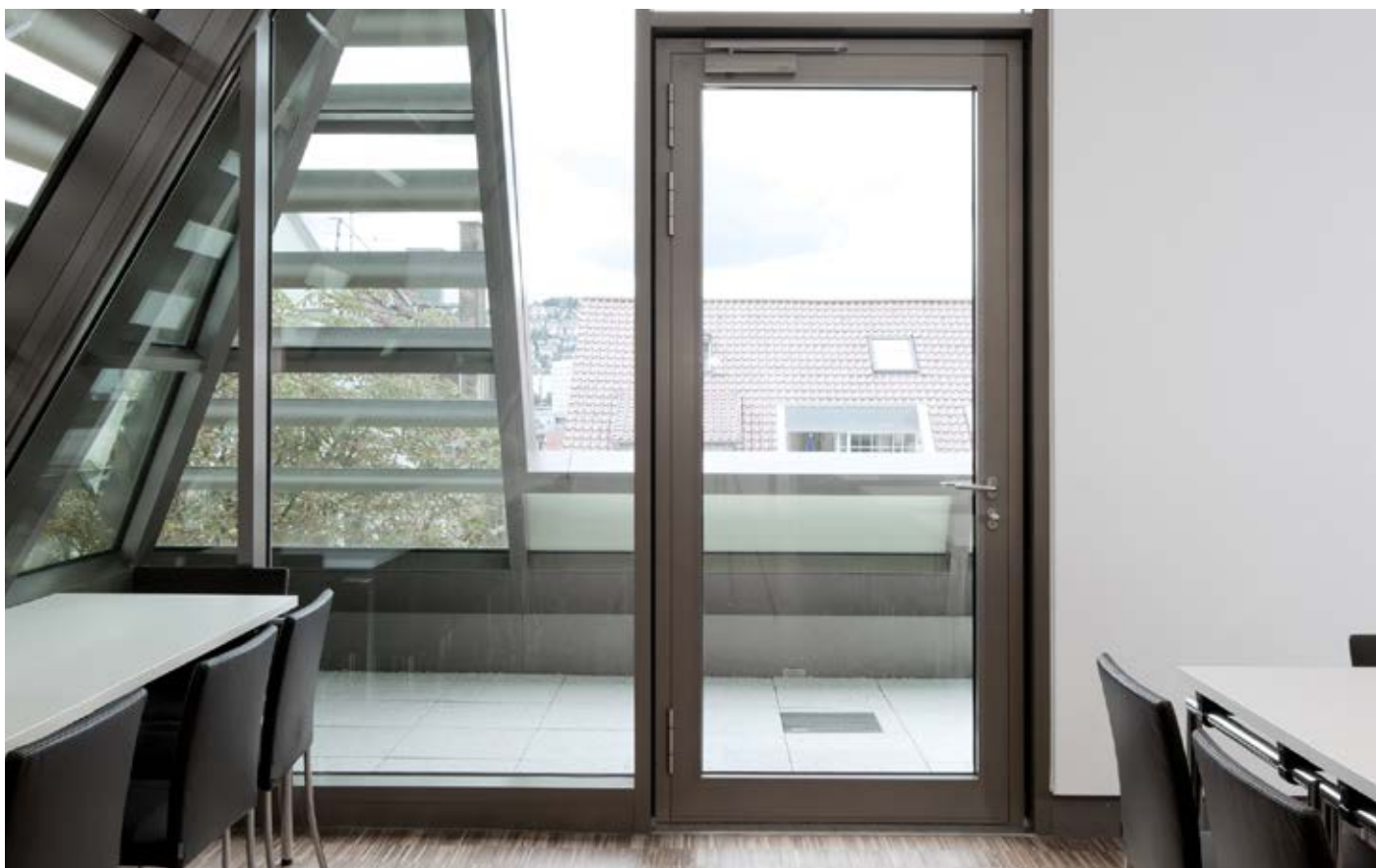
TS 5000 mit T-Stop-Gleitschiene, Verwaltung Katholische Kirche, Stuttgart, Deutschland (Foto: Dirk Wilhelmy)
